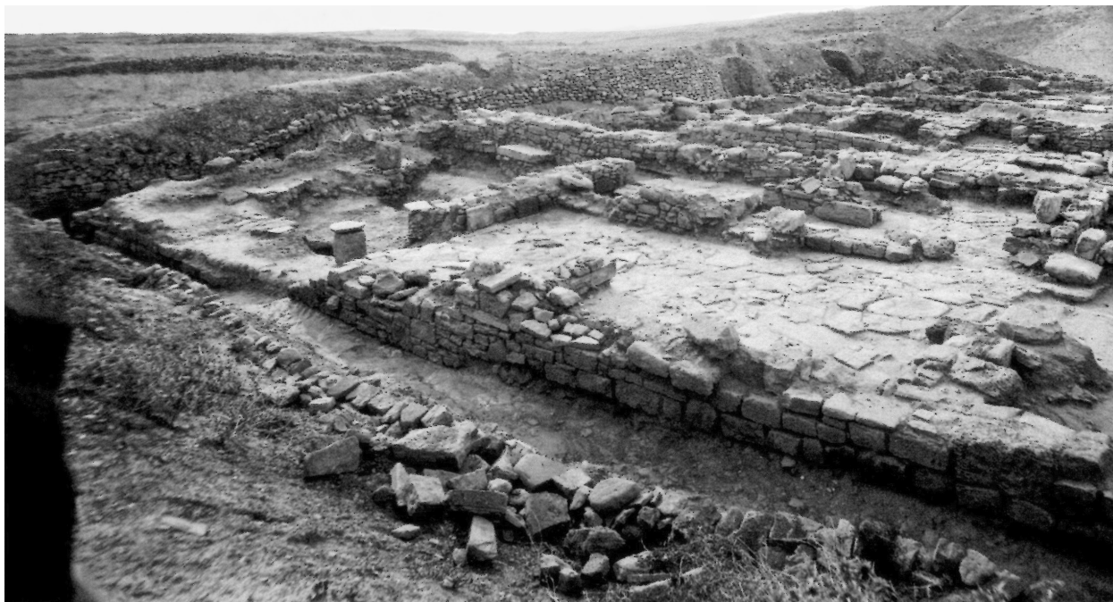
Fig. 5 - Efestia. Il quartiere insediativo ellenistico nel 1930, settore sud-orientale: particolare dell'incrocio stradale lastricato inglobato nelle case (da FICUCIELLO 2013, fig. 103a)
